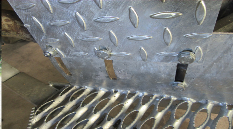
Schutzblech wird mit 2 Schrauben 10x25 befestigt
